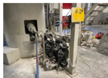
DÁVKOVÁNÍ CEMENTOVÝCH ADITIV
